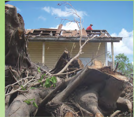
Recuperando materiales para reparar el techo.
