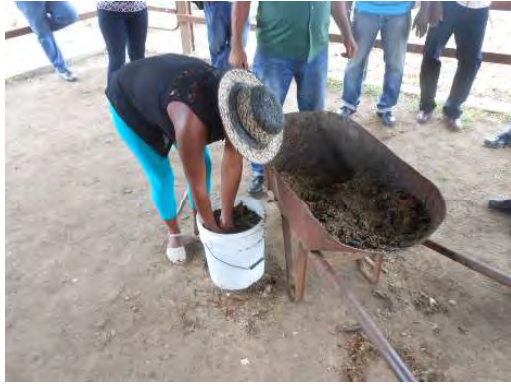
Compactación de la mezcla con la ayuda de los puños
